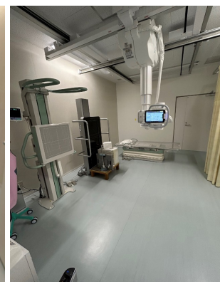
Fig.4 X線管懸垂器
