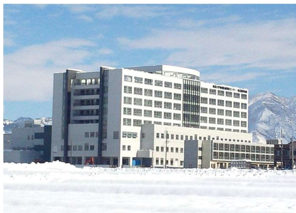
図 1 大自然に囲まれた魚沼基幹病院の外観
